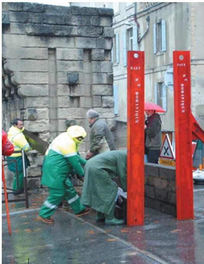
Crue du Rhône - Avignon - mise en place d'un batardeau décembre 2003
